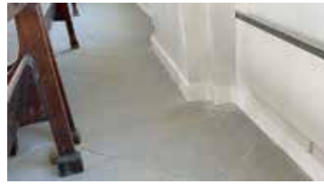
■ Auf beiden Emporensiten wurden in Kabelkanälen mehrere Kabelstränge von West nach Ost verlegt: aufwändig um viele Ecken geführt
