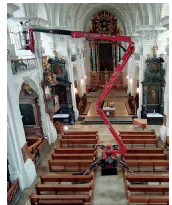
Aufwändige Reinigungsarbeiten am Stuck, den Kapitellen und Wänden
