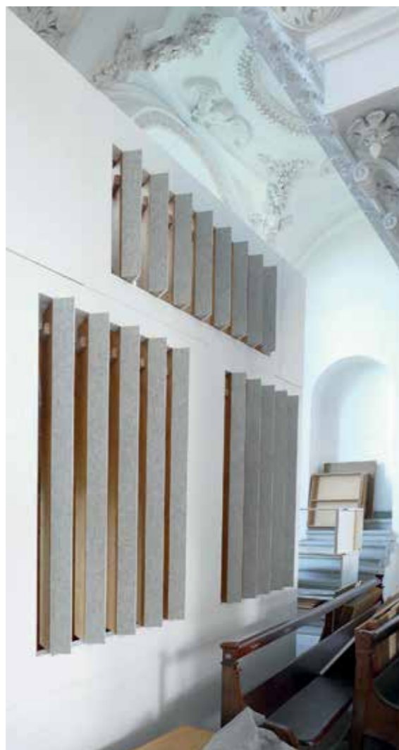
■ Das Anglikanische Schwellwerk* : in der gleichen Farbe gehalten wie der architektonische Hintergrund und auf der Nordempore an die Außenwand gesetzt – somit optisch weitgehendst unauffällig. Bei diesem Blickwinkel auf die Stirnseite der Jalousieelemente ist deren 10 cm dicke Stärke gut zu erkennen.
